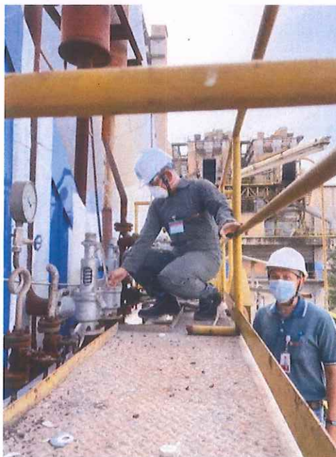
ภาพการตรวจสอบการทำงานลิ้นนิรภัยของหม้อน้ำ AQC
